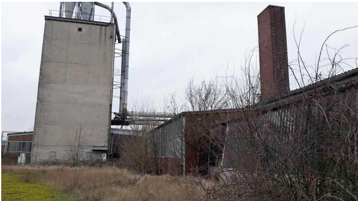
Abb. 7: Südseite der ehemaligen Möbelfabrik, links im Bild Silogebäude (03.02.2022).
